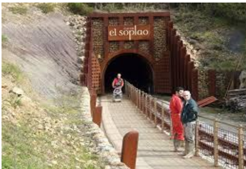
Mina subterránea rehabilitada
